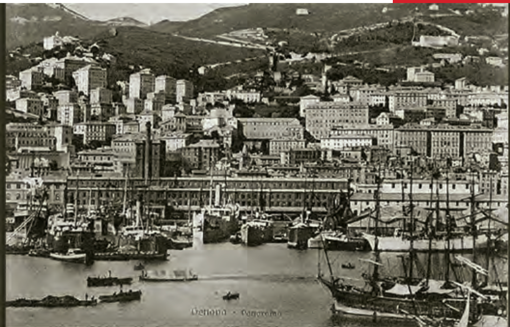
Vista do Porto de Gênova
