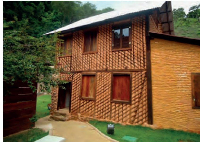
Casa Lambert, costruita nel 1875 dai fratelli italiani Antônio e Virgílio Lambert, uno dei primi edifici a Santa Teresa (ES)
